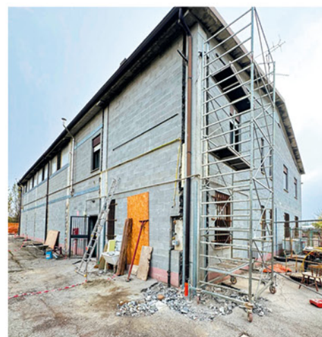
Il cantiere nella sede del CMP
