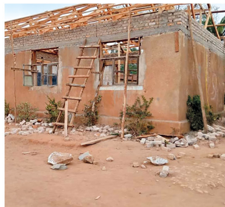
La scuola in costruzione a Kifumbe
