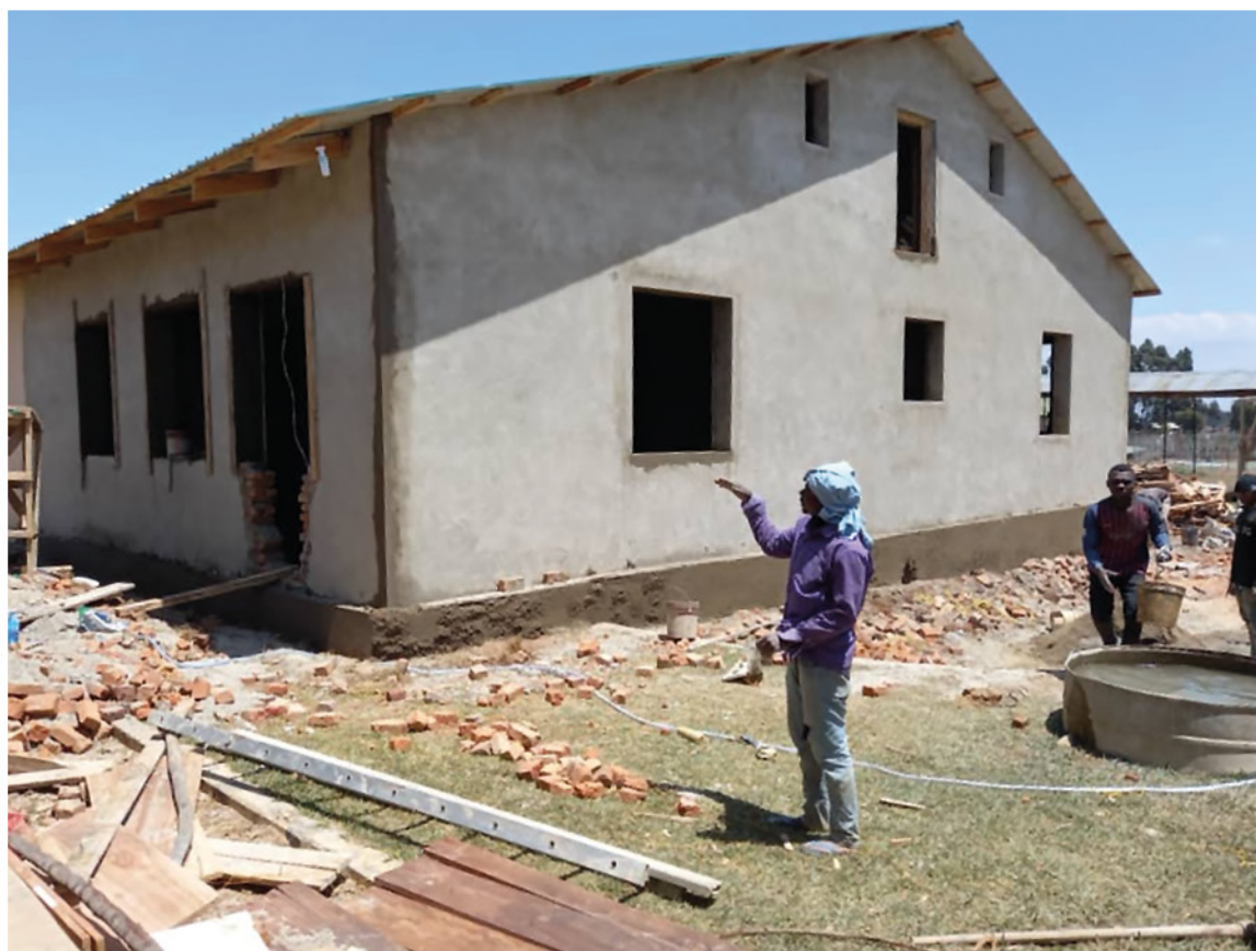
Nuova sala operatoria in costruzione all'ospedale di Ikelu
