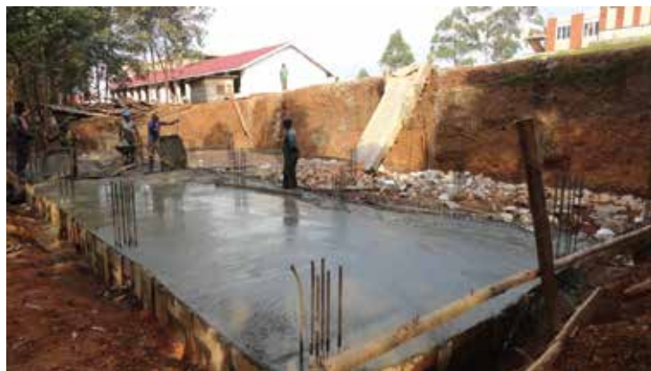
Lavori per il Refettorio e la Cucina
